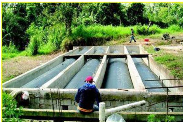
**Figura 23 Biodigestores tipo tubular cuádruple r expuesto al aire libre, pudiendo techarse para una mejor conservación.**
